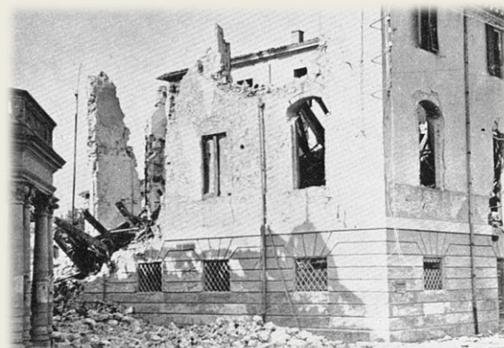
Una parte del palazzo del Municipio demolito dai bombardamenti
