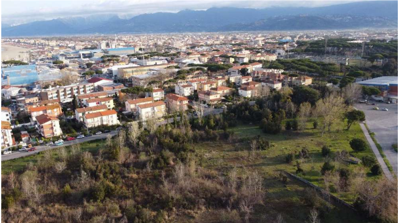
Area 5, vista alla zona Darsena verso nord - da drone (marzo 2023)
